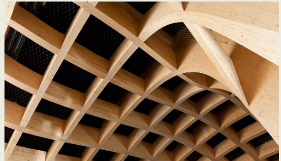
Exemple de structure utilisant des poutres en bois lamellé-collé (Exposition Universelle Milan 2015, Pavillon France, Architecte : X-Tu, Photo : Andrea Bosio)
